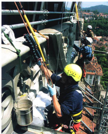
Abb. 18. Bauservice am Berner Münster: Mit Ölfarbe gefasste Brüstung am oberen Viereckskranz (Langzeitversuch an einem ursprünglich bereits aufgegebenen freistehenden Bauteil). Im Bild: Nachölen der Brüstung im Sommer 2007.
