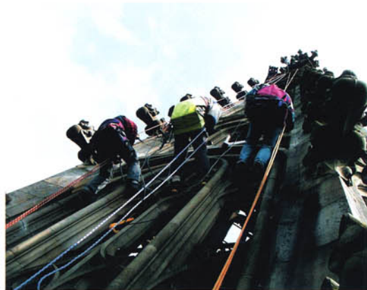
Abb. 17. Bauservice am Berner Münster: Kontrolle und Notmassnahmen am Turmhelm, (2001, 2003, 2004 zusammen mit einem Bergführer im Seil)
