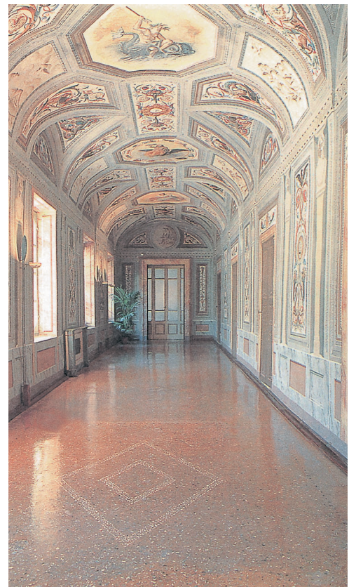
Abbildung 4: Pompejanische Galerie. Die haustechnischen Leitungen sind auf den Bauteilen montiert: Am Sockel der Außenwände unter einem Mörtelprofil die beiden Heizrohrschleifen, davor auf dem Boden unter einer hohlen Stuhlleiste die elektrischen Leitungen, die auch die vor der Wand montierten Standleuchten versorgen. Foto Alberto Grimoldi, Mailand.
