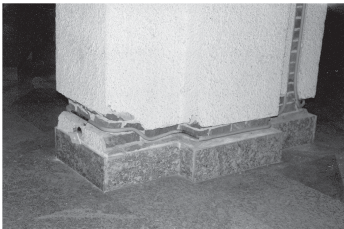
Abbildung 8a u. b: Kirche Sacro Cuore. Einbau der Temperierung. Der Putz mußte nicht erhalten werden. Fotos Autor.
