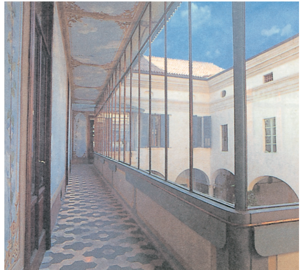
Abbildung 4: Pompejanische Galerie. Die haustechnischen Leitungen sind auf den Bauteilen montiert: Am Sockel der Außenwände unter einem Mörtelprofil die beiden Heizrohrschleifen, davor auf dem Boden unter einer hohlen Stuhlleiste die elektrischen Leitungen, die auch die vor der Wand montierten Standleuchten versorgen. Foto Alberto Grimoldi, Mailand.
